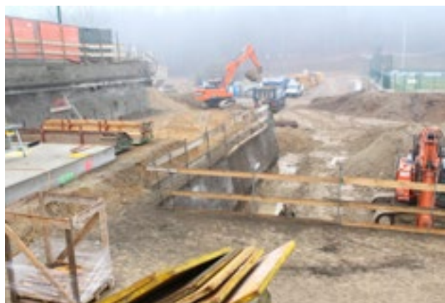
Il cantiere di Maso Ronco dove sorgerà la nuova sede amministrativa del nostro club
